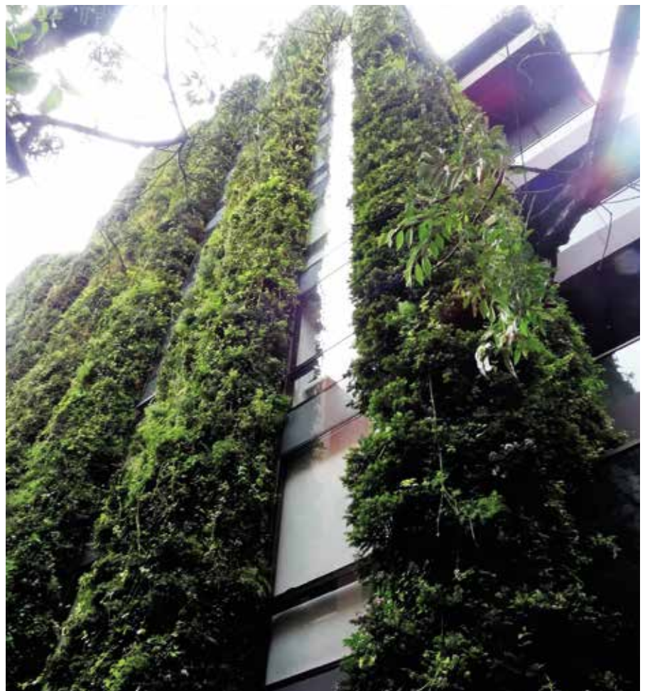
Edificio naturado Santalaia. Bogotá
