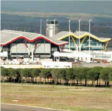
Terminal 4 del Aeropuerto de Barajas
